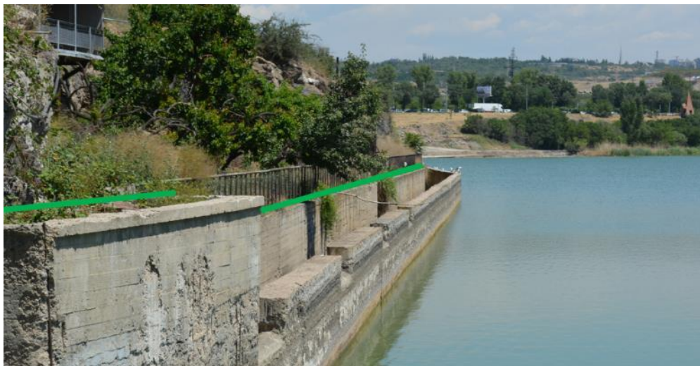
Նկար 7. Մինչև ամբարտակի ենթակայանը ջրհեռի վրա մալուխի դիրքը
