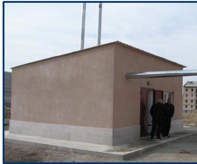
Մի քն՝ ծի ՊՊԾ. ՉհԱՇԻՇ ԱՇԻ 8 1ձհնոՇ ԻՅ ԱեՅ ԼԵ՛ ԻՅ ԳԻՅ: ԵՇԿՅն քն քն ԻՅ Կ Յ ԵՅ՛ ԻՅ Կն ԿնՅնՅ Յ ԻՅ քն Ծո Նն՛ Ե: Photo R2E2 Fund: Boiler house in Artik number 8 school. After the completion of construction works.
