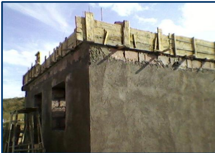
Մի քն՝ ծի ՊՊԾ. ՉհԱՇԻՇ ԱՇԻ 8 1ձհնոՇ ԻՅ ԱեՅ ԼԵ՛ ԻՅ ԳԻՅ Ենոնոն: Photo R2E2 Fund: Construction of boiler house in Artik number 8 school.
