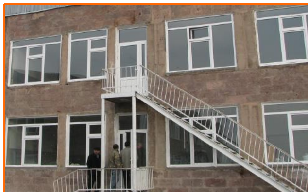
ÞÇÝ³ ñ³ ñ³ Ì³ Ý³ Ñ ÒË³ Ì³ Ñ ÝùÝ»ñÇ³ Ì³ ñ³ Çó Ñ»í á: After the construction works
