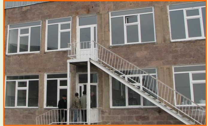
Շինարարական աշխատանքների ավարտից հետո: After the construction works
